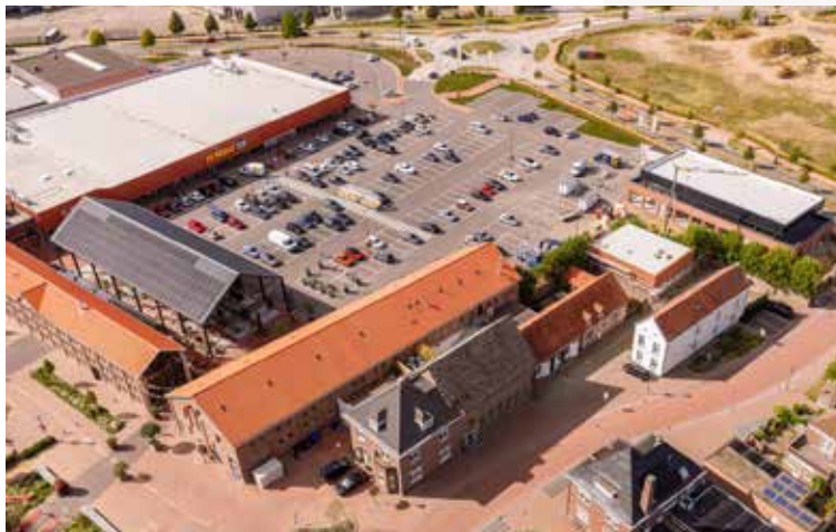
> De Pannenfabriek, gelegen aan de Aasterbergerweg
